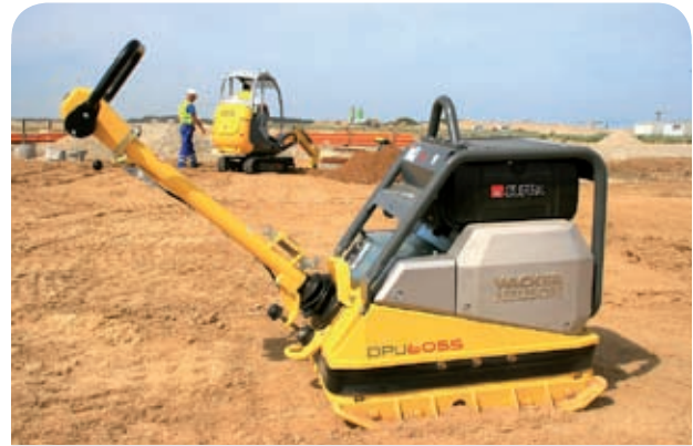
Zahlreiche Einsatzsituationen unserer Kunden zeigen, wie gut sich Light und Compact Equipment der Marke Wacker Neuson auf dem Bau ergänzen.
