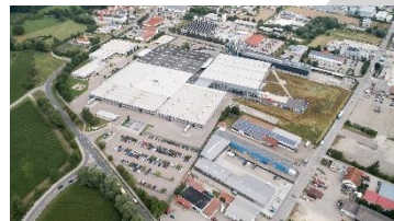
Reichertshofen (DEU) Baugeräte
