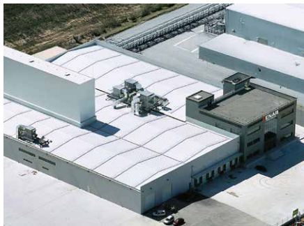
Saragossa (ESP) Baugeräte
