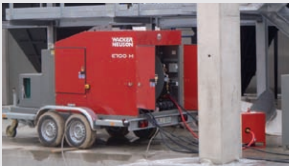
Betonierarbeiten sind im Winter nicht oder nur unter schwierigsten Umständen durchführbar. Dank des Einsatzes eines Flächenheizers E 700M von Wacker Neuson konnte der Bau zweier Industriehallen in Deutschland fortgeführt werden.
